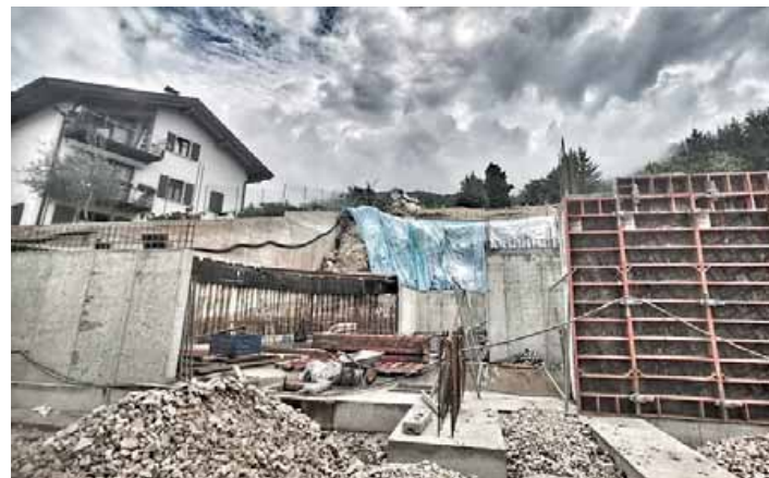
Uno dei cantieri a Villazzano:
